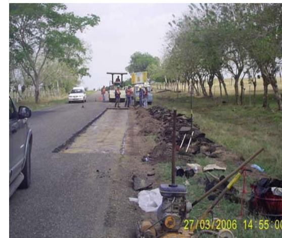
Trabajos de Fresado y Reciclado en el K8+200 Betulia – Sincé y la Señalización Respectiva Fresadora Caterpillar
