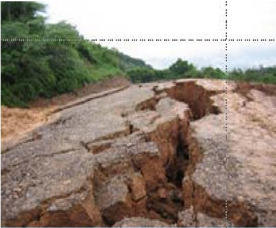
**BANCA DE LA VIA TOTALMENTE AGRIETADA Y FALLADA**
