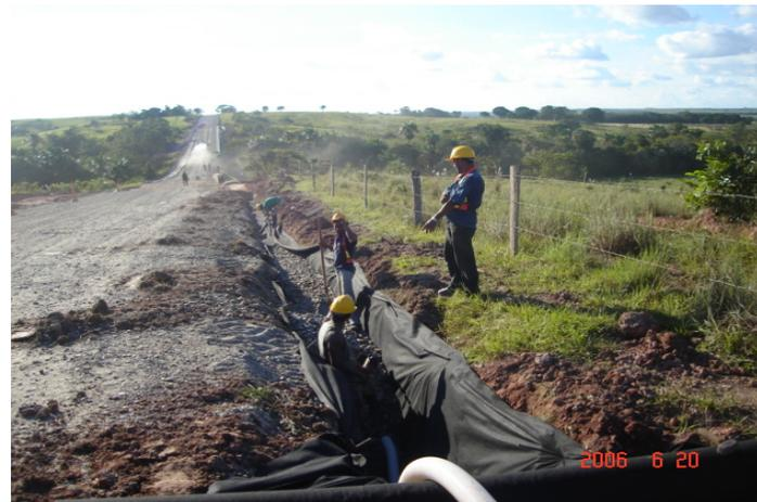
**CONSTRUCCION DE FILTROS CON MANGUERA PERFORADA TRAMO 2(P).**
