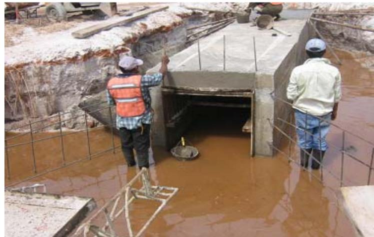
**BOX COULVERT EN EL K4+070 FUNDIDO COMPLETAMENTE**
