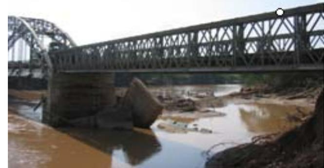
MONTAJE PUENTE PROVISIONAL TIPO MABEY CON UNA LONGITUD DE 39 mts
