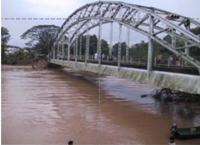
ESTRUCTURA METALICA EN ARCO ATIRANTADO DE 60 mts DE LUZ
