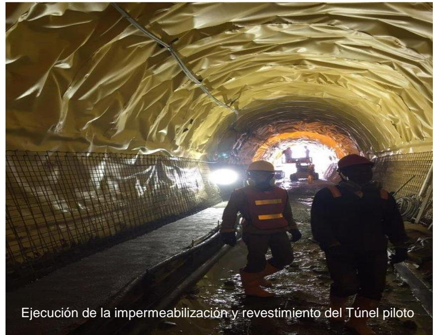
Ejecución de la impermeabilización y revestimiento del Túnel piloto
