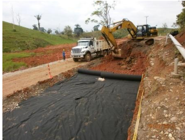
Explanación en k99+680 – k99+787 margen izquierda
