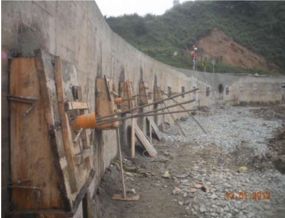
Foto No 2: Vista de construcción de anclajes de L=20,0 m. km10+615 al km10+690 Para garantizar la estabilidad del muro de contención. Segunda Calzada Quindío
