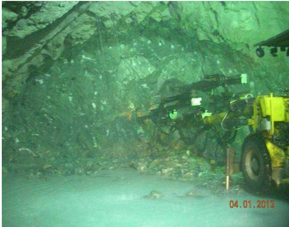
Foto No 1: Túnel II Centenario Frente Quindío- Avance Desde Galería No 5 hacia Quindío Se observa en la foto: La barrenación del frente de excavación para avance.
