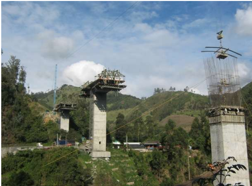
Foto No 3: Vista del Viaducto “Las Marías” km 40+520 al km 40+843. Segunda Calzada del Tolima Se observa en la foto: Trabajos de construcción dovelas voladizas y módulo de elevación No 12 de la Pila 3.
