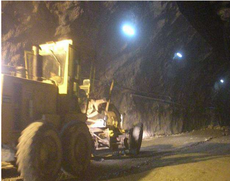
Foto No 1: Túnel II Centenario Frente Tolima- Céreo de la Sub-rasante km8+600 al km8+400
