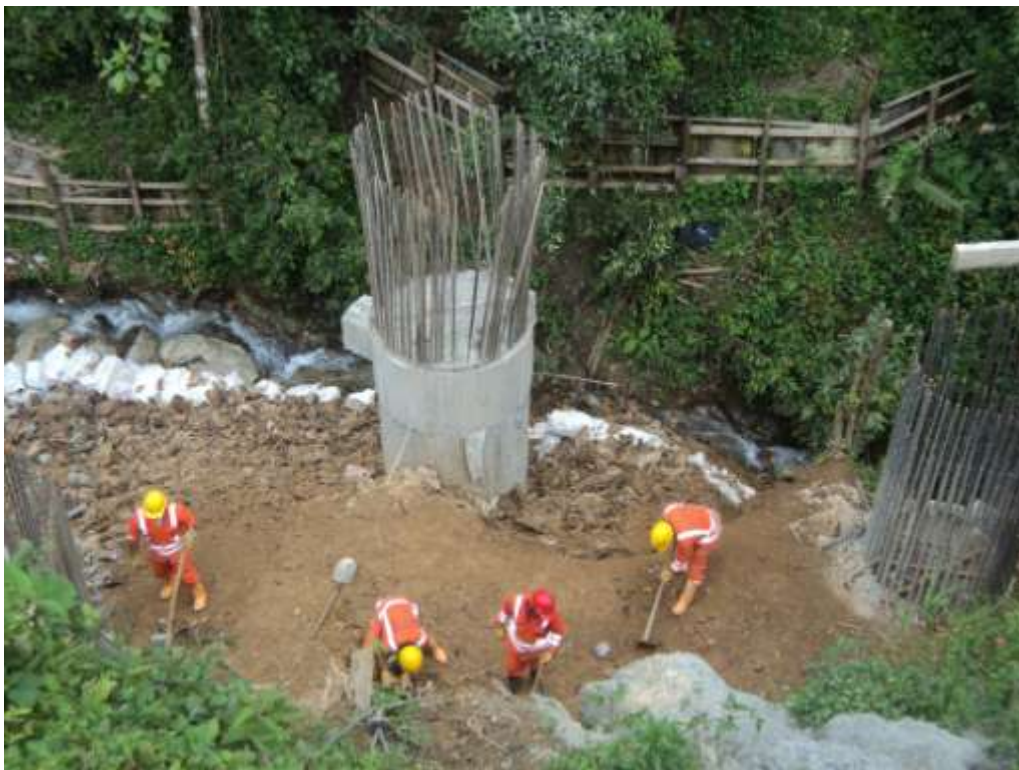
Foto No 2: Viaducto “El Salado”, localizado entre el km7+890 y el km8+060 Segunda Calzada Quindío. Se observa la construcción de los Caissons de la Pila No 1
