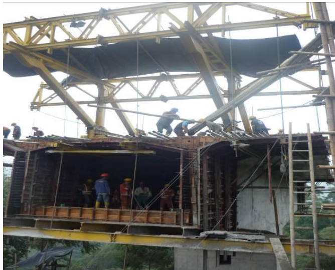
Foto No 3: Puente “El Roblecito”, localizado entre el km9+890 y el km10+090 Segunda Calzada Quindío. Se Observa: Inicio trabajos de construcción Dovelas
