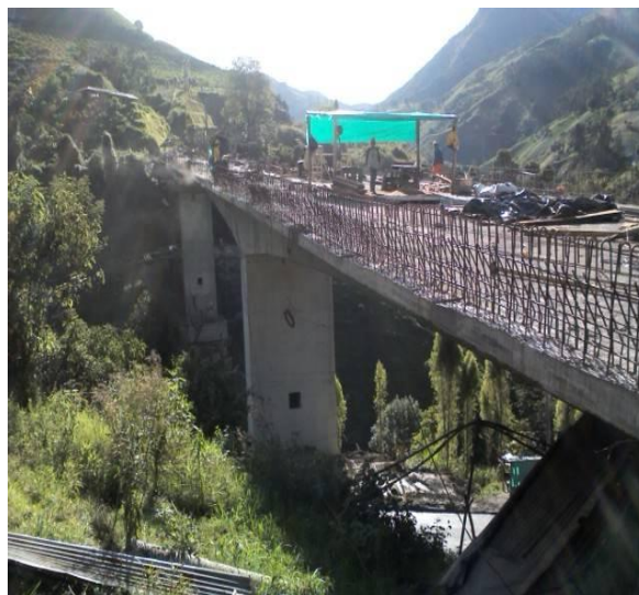
Foto No 2: Puente "Porvenir", localizado en el Km42+520 al Km42+677,50. Se observa el armado de acero para construcción de barreras de tráfico.
