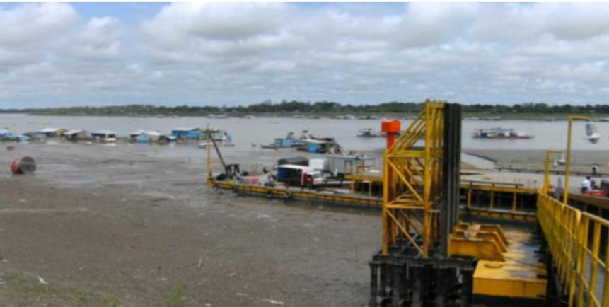
Adecuación del muelle mediante el dragado de 250.000 m<sup>3</sup> de material en la zona de maniobras del muelle y la parte del canal de acceso, con el fin de garantizar la flotabilidad del muelle de carga Victoria Regia.
