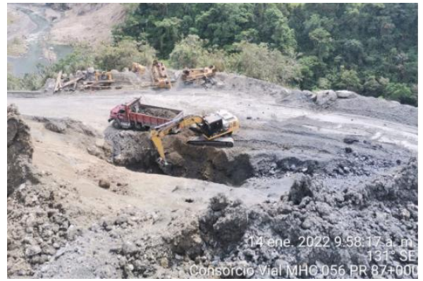
PR87+0000 Caída de banca Vía Sogamoso – Aguazul 15 de enero de 2022 Monitoreo: CDGRD, CMGRD, Bomberos y Policía de Pajarito, Contratista Consorcio Vial MHC 056, Interventoría Consorcio Terra CGS Fuente: Contratista Consorcio Vial MHC 056
