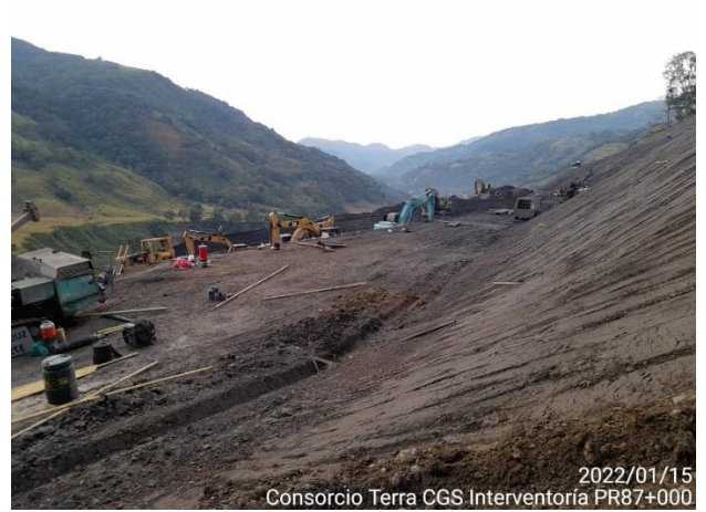
PR87+0000 Caída de banca Vía Sogamoso – Aguazul 15 de enero de 2022 Monitoreo: CDGRD, CMGRD, Bomberos y Policía de Pajarito, Contratista Consorcio Vial MHC 056, Interventoría Consorcio Terra CGS Fuente: Interventoría Consorcio Terra CGS
