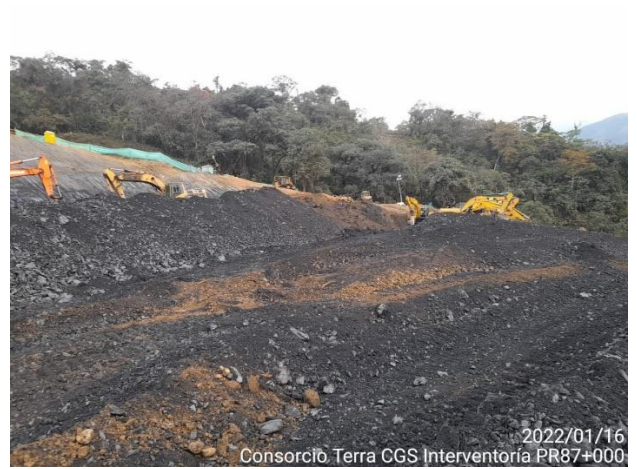
2022/01/16 Consorcio Terra CGS Interventoría PR87+000
