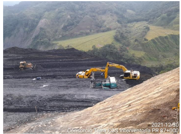
2021-12-30 Consorcio Terra CGS Interventoría PR 87+000
