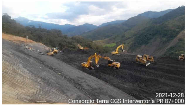
2021-12-28 Consortio Terra CGS Interventoría PR 87+000
