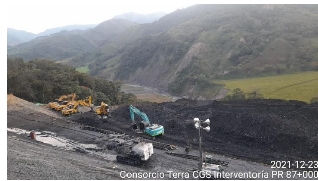
2021-12-23 Consorcio Terra CGS Interventoría PR 87+000
