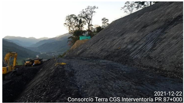
2021-12-22 Consorcio Terra CGS Interventoría PR 87+000
