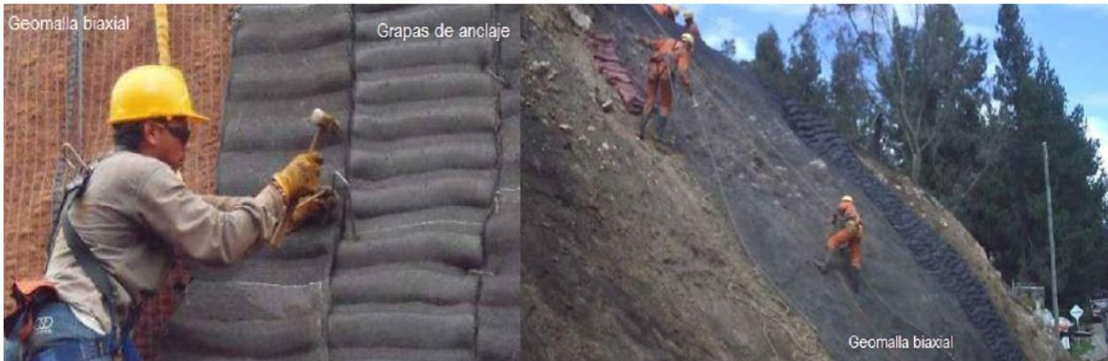
Figura 850-5. Instalación geobiomalla
