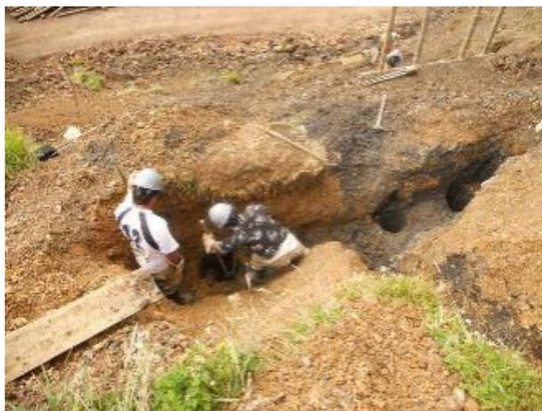
Figura 840 - 4. Perforación para instalación de las guadas/estacones al interior de una zanja. Navarro Wolf, Jorge (2015) II seminario de bioingeniería de Bogotá.
