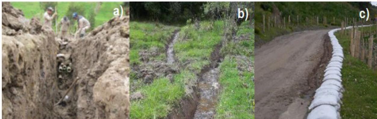
Figura 840-1. a) Filtros vivos, b) Zanjas de drenaje y c) Gusanillos. Navarro Wolf, Jorge (2015) II seminario de bioingeniería de Bogotá.
