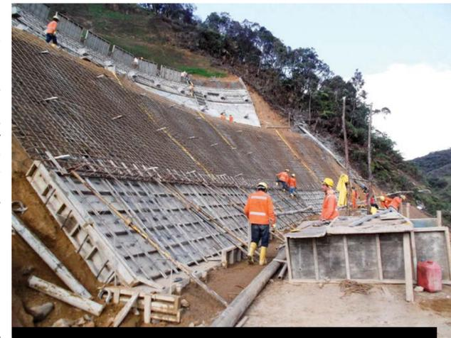
Trabajos de estabilización de taludes con anclajes.
