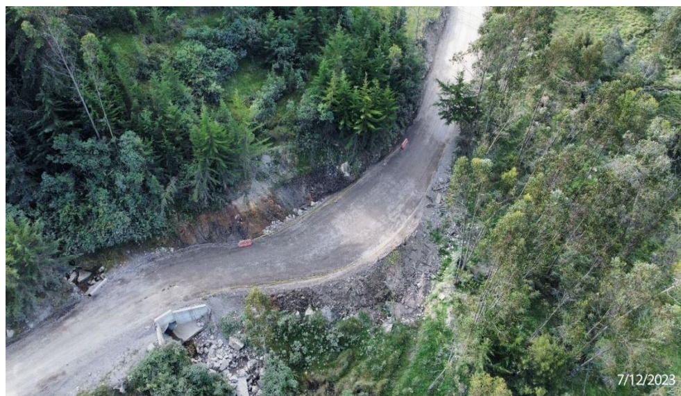
Panoramica (después) (Fecha de foto: 7/12/2023)
