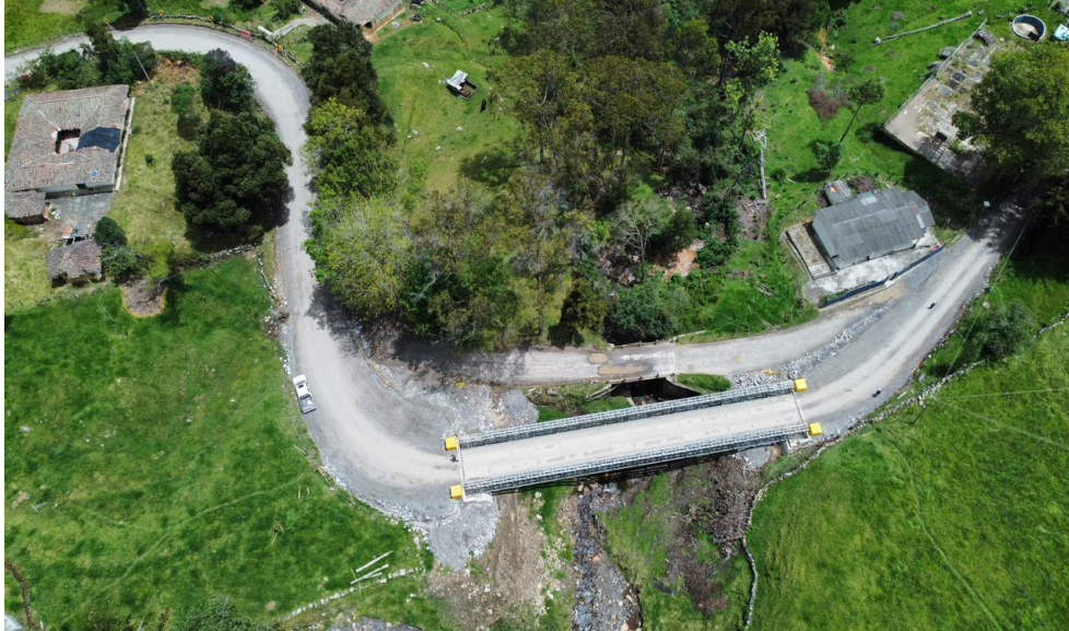
Panoramica (después) (Fecha de foto: 6/08/2024)
