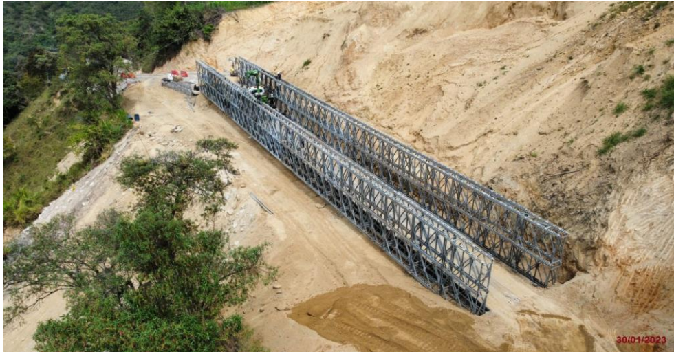
Puente metálico PR111+350 (Fecha de foto: 30/01/2023)
