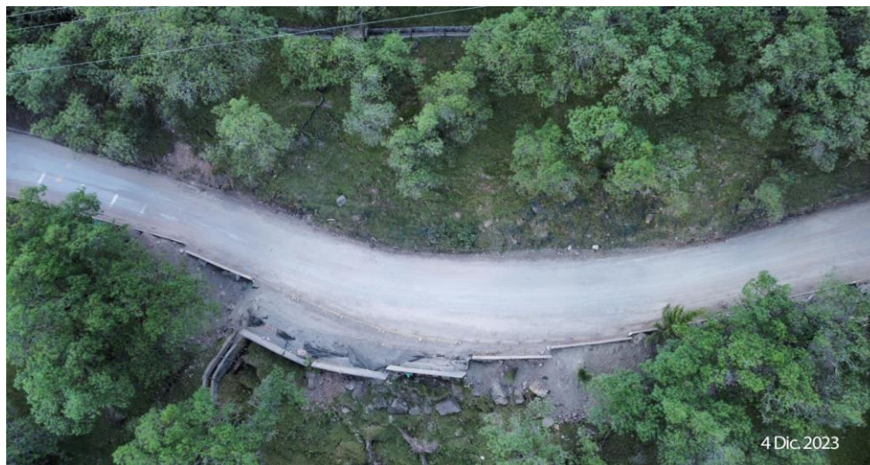
Panoramica (después) (Fecha de foto: 4/12/2023)
