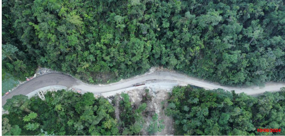
Panoramica (después) (Fecha de foto: 10/08/2024)
