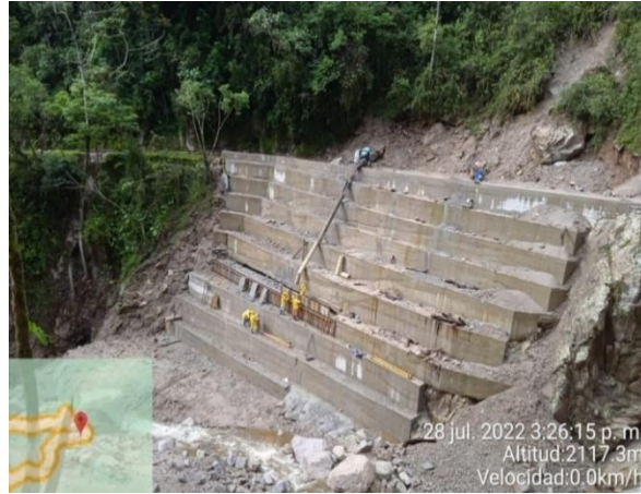
Antes (Fecha de foto: 23/03/2022) y después (Fecha de foto: 28/07/2022) Construcción muro de contención en pérdida de banca PR88+400.
