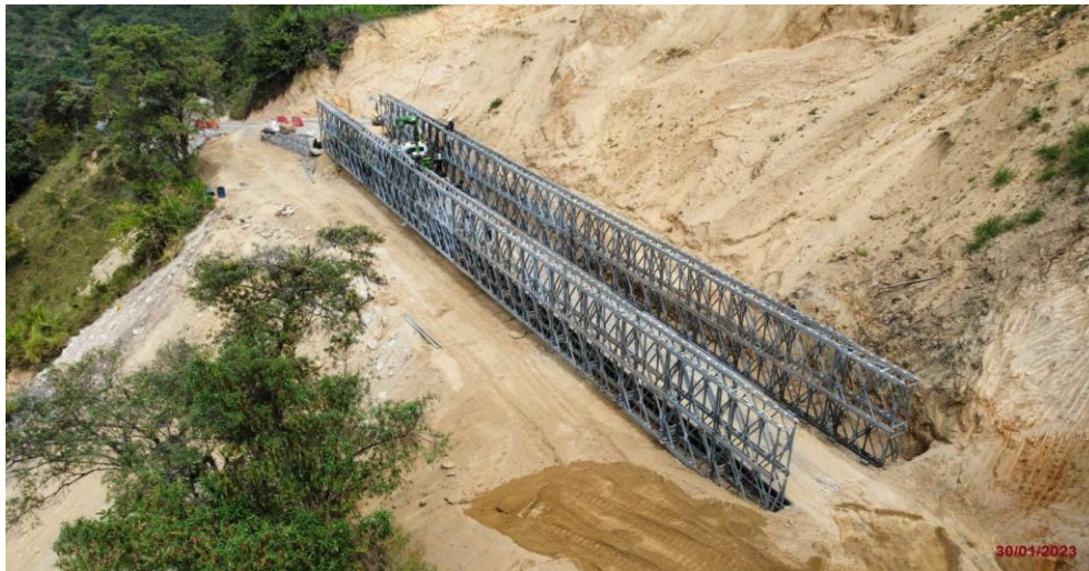
Puente metálico PR111+350 (Fecha de foto: 30/01/2023)
