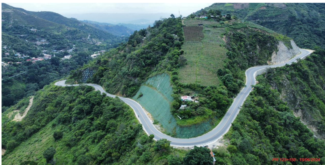
Panorámica después (Fecha de foto: 15/06/2024) PR123+150. Pavimentación y señalización de la vía. Sector atendido y a la fecha se encuentra igual.
