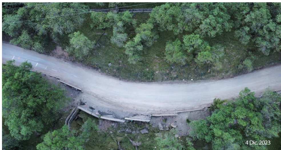
Panoramica (después) (Fecha de foto: 4/12/2023)
