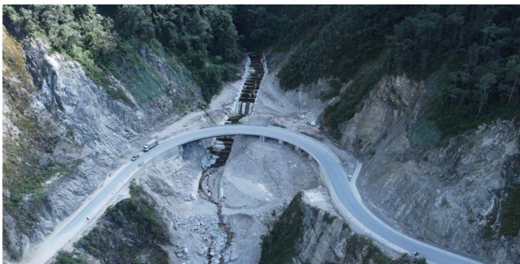
Ejecución en sitio La Judía (Fecha de foto: 15/01/2025), PR79+700. Construcción de puente.
