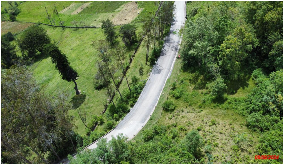
Panoramica (después) (Fecha de foto: 6/08/2024)
