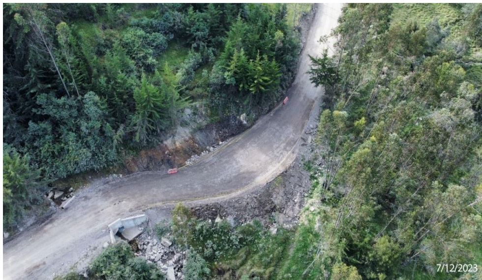
Panoramica (después) (Fecha de foto: 7/12/2023)
