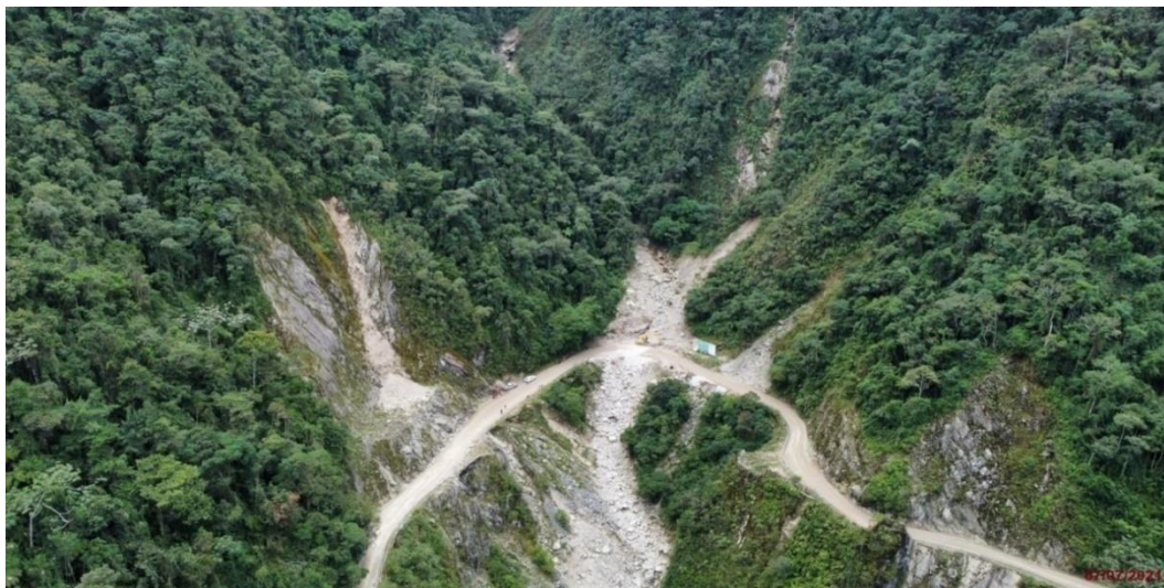
Antes sitio La Judía (Fecha de foto: 07/07/2021), PR79+900. Cauce con alto depósito de materiales.
