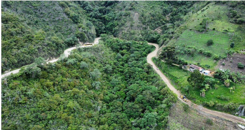
Panoramica – Actividades de mantenimiento.
