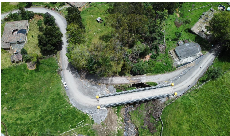
Panoramica (después) (Fecha de foto: 6/08/2024)
