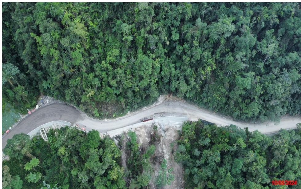
Panoramica (después) (Fecha de foto: 10/08/2024)
