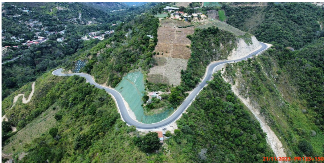
Panorámica antes (Fecha de foto: 21/11/2023) PR123+150. Pavimentación de la vía. Sector atendido y a la fecha se encuentra igual.
