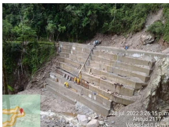
Antes (Fecha de foto: 23/03/2022) y después (Fecha de foto: 28/07/2022) Construcción muro de contención en pérdida de banca PR88+400.
