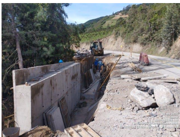
Antes (Fecha de foto: 26/10/2024) y después (Fecha de foto: 11/01/2025) PR64+380 Ampliación y pavimentación de la vía
