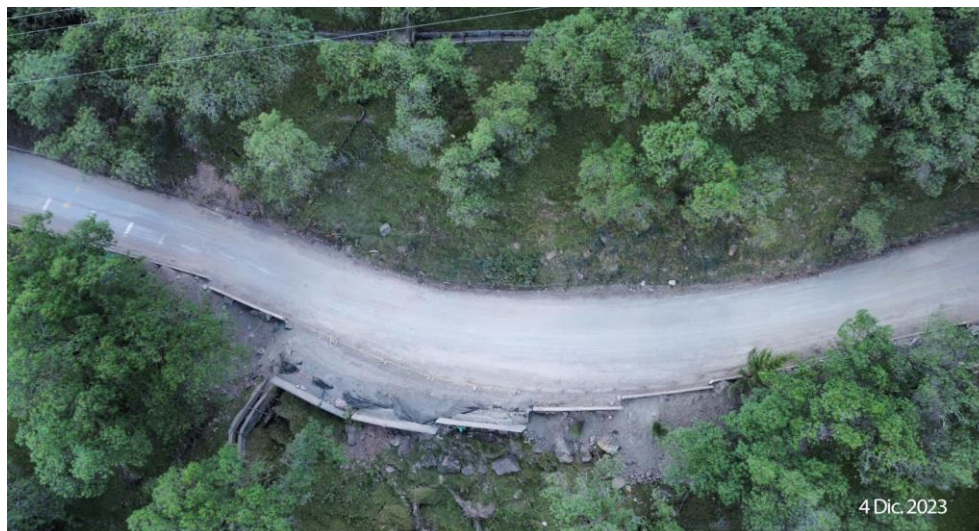
Panoramica (después) (Fecha de foto: 4/12/2023)
