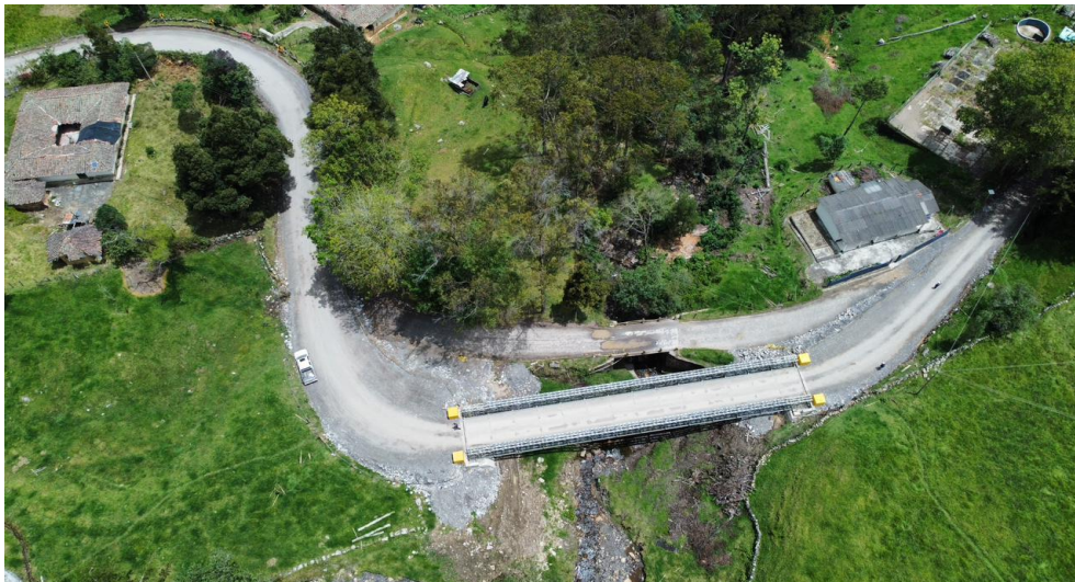
Panoramica (después) (Fecha de foto: 6/08/2024)
