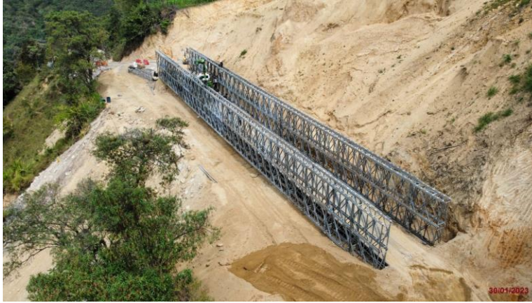
Puente metálico PR111+350 (Fecha de foto: 30/01/2023)
