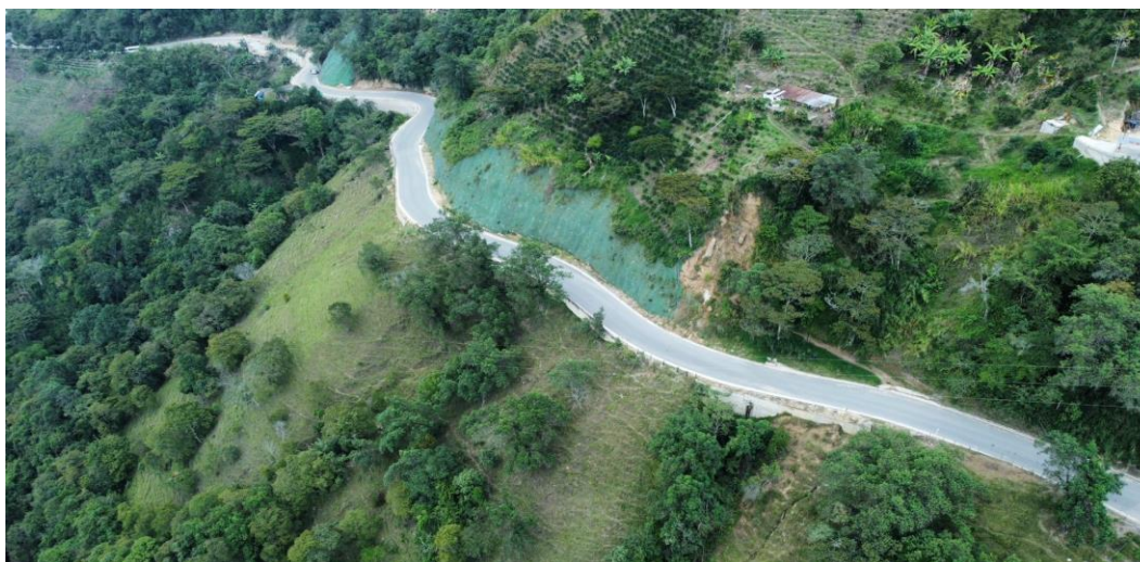
Panorámica (Fecha de foto: 15/05/2024) PR110+400. Pavimentación de la vía. Actualmente el sector se encuentra igual.
