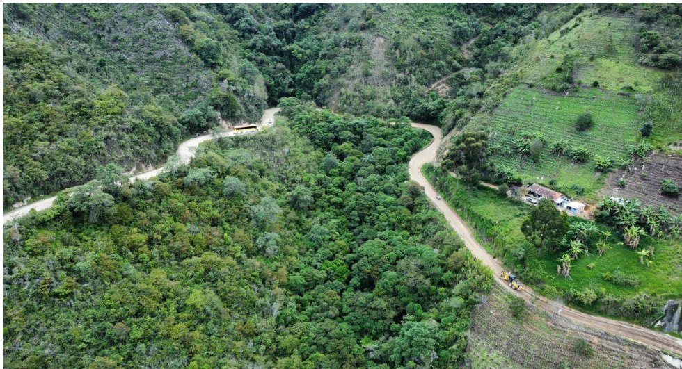
Panoramica – Actividades de mantenimiento.
