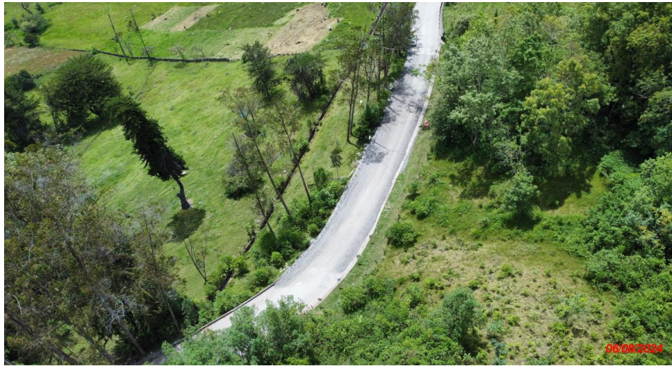
Panoramica (después) (Fecha de foto: 6/08/2024)
