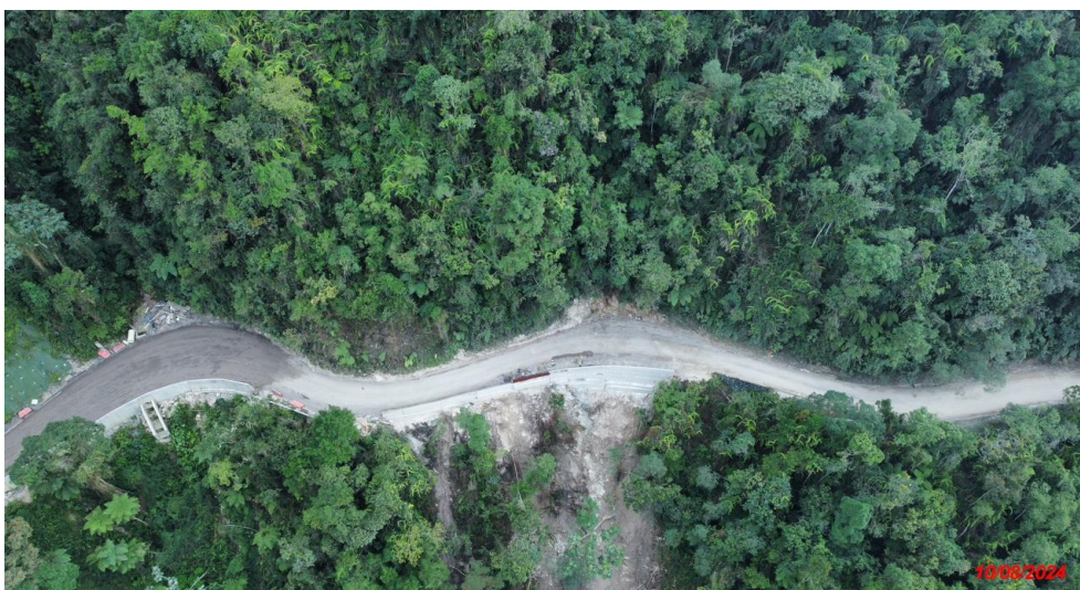
Panoramica (después) (Fecha de foto: 10/08/2024)
