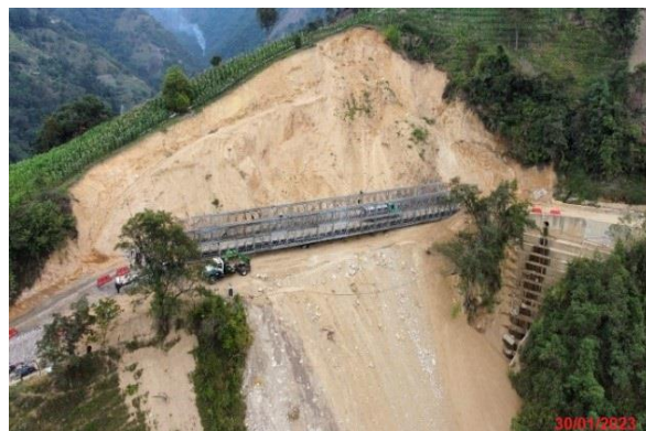
Antes (Fecha de foto: 24/11/2022) y después (Fecha de foto: 30/01/2023). Atención de la emergencia en el PR111+350. Instalación de puente metálico.
