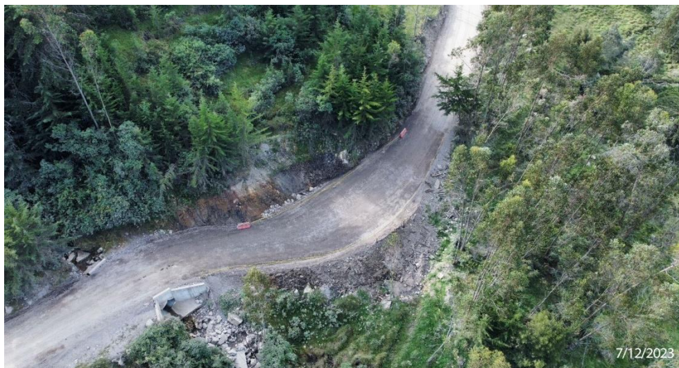
Panoramica (después) (Fecha de foto: 7/12/2023)
