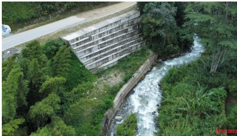
Después (Fecha de foto: 23/01/2023), PR95+250. Obras de protección a la vía.
