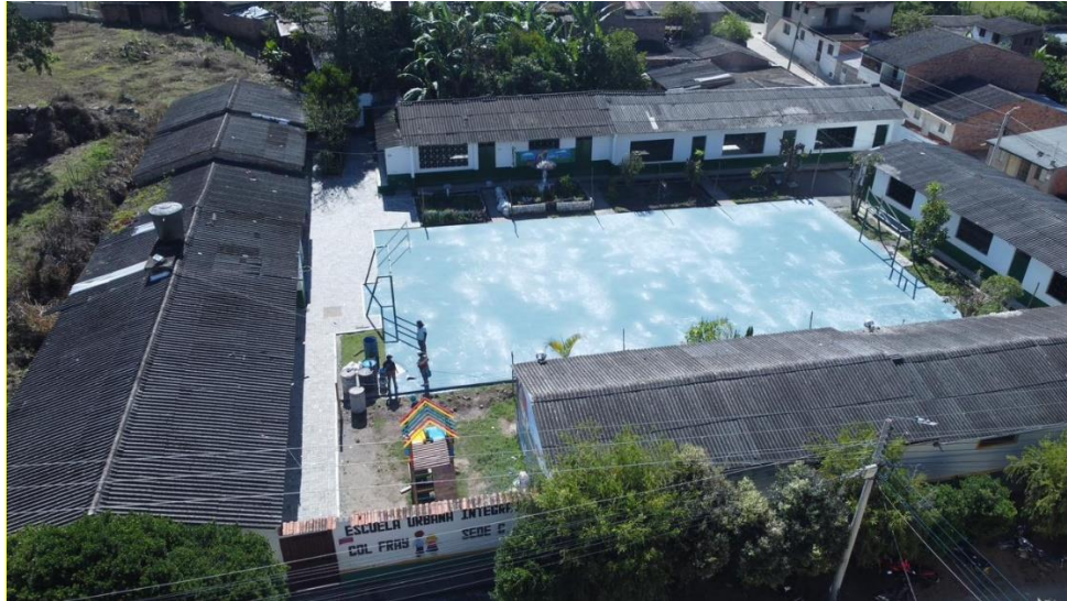
Instalación de pintura para cancha
