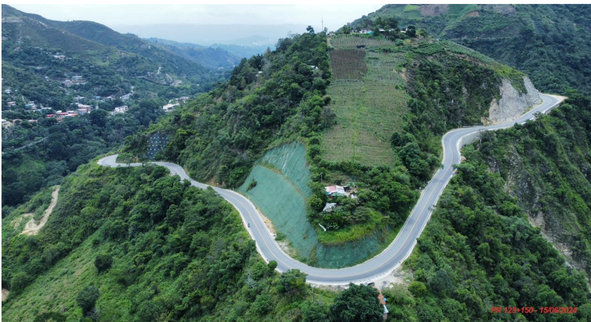
Panorámica después (Fecha de foto: 15/16/2024) PR123+150. Pavimentación y señalización de la vía. Sector atendido y a la fecha se encuentra igual.
