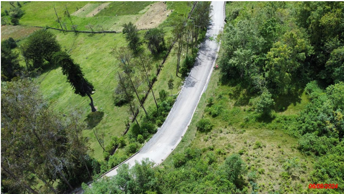
Panoramica (después) (Fecha de foto: 6/08/2024)
