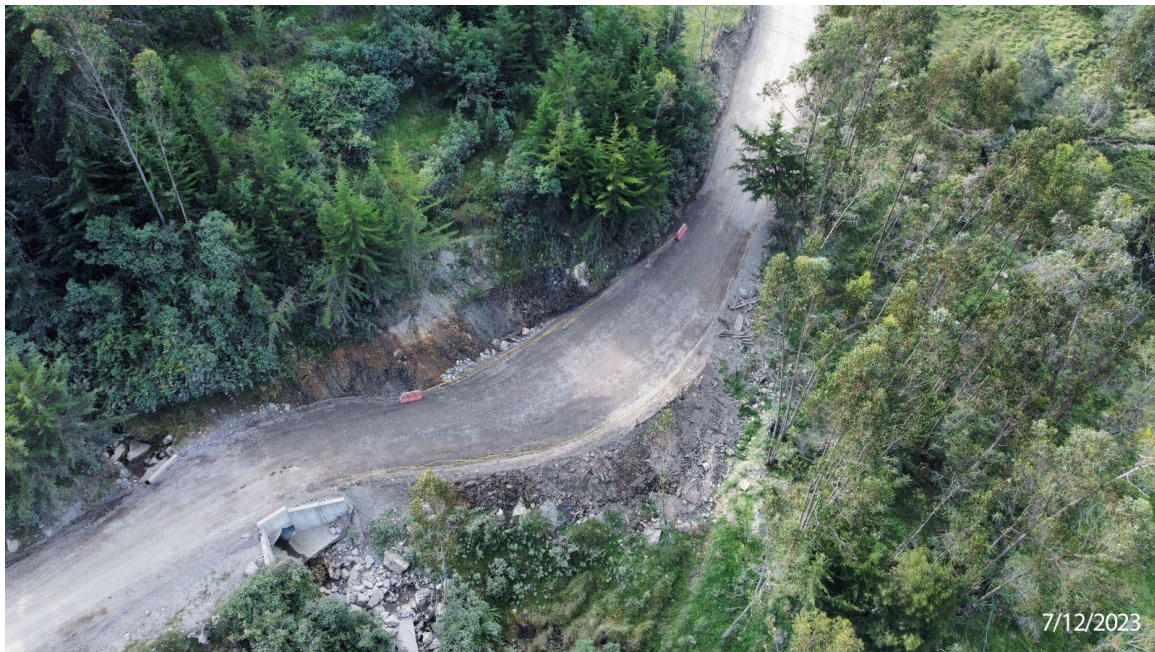
Panoramica (después) (Fecha de foto: 7/12/2023)
