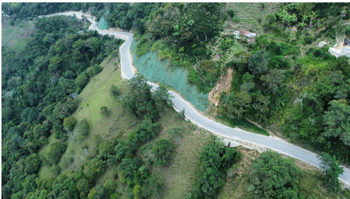
Panorámica (Fecha de foto: 15/05/2024) PR110+400. Pavimentación de la vía. Actualmente el sector se encuentra igual.
