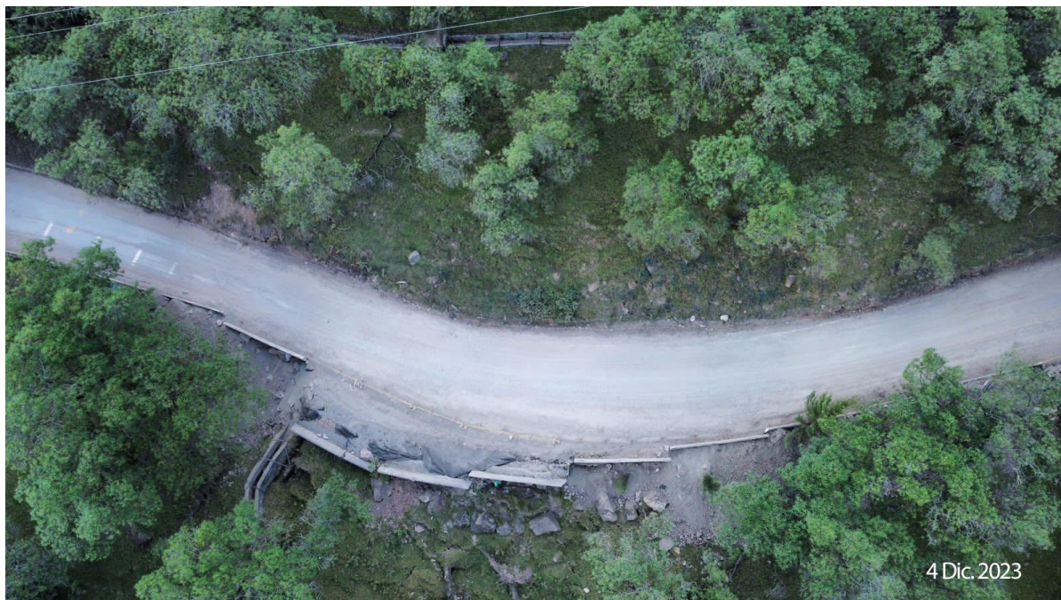
Panoramica (después) (Fecha de foto: 4/12/2023)
