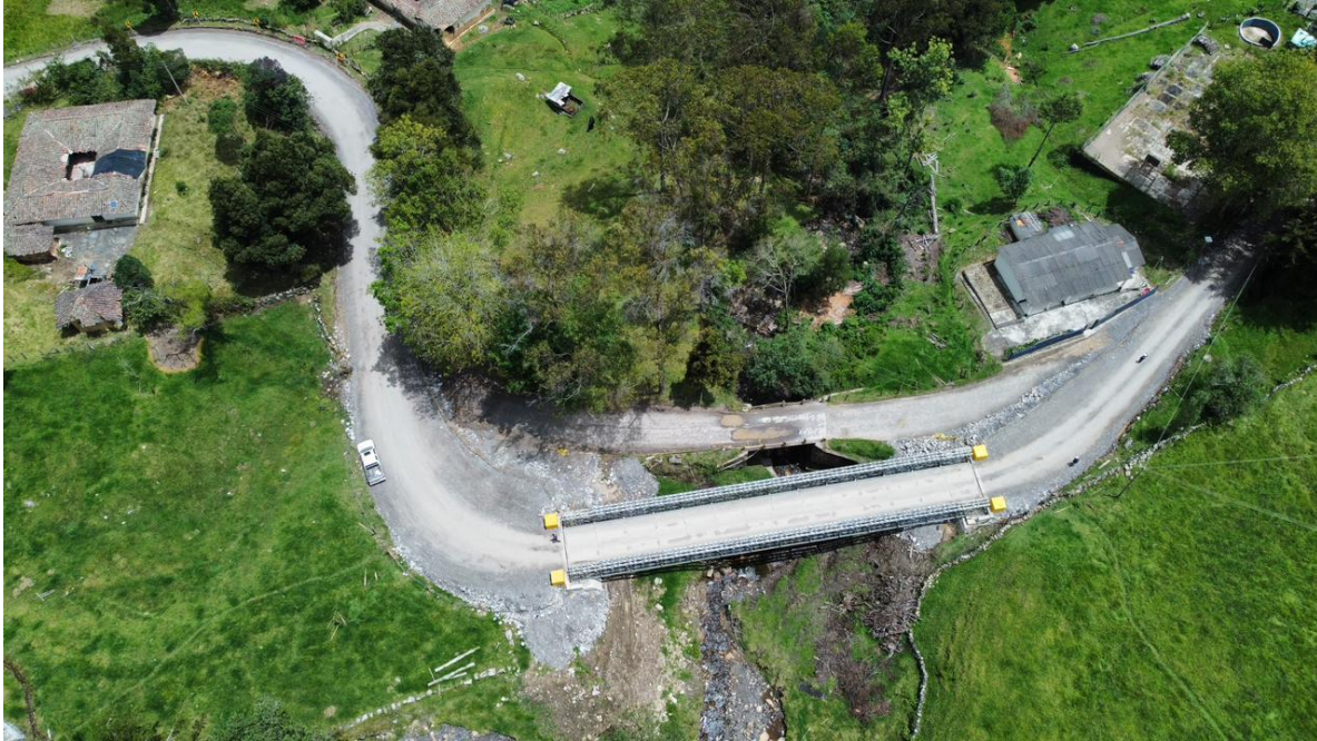
Panoramica (después) (Fecha de foto: 6/08/2024)
