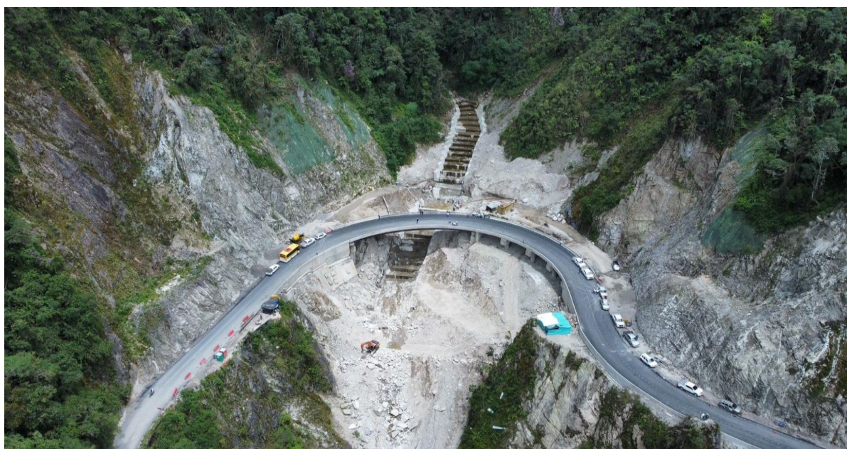
Ejecución en sitio La Judía (Fecha de foto: 15/09/2024), PR79+700. Construcción de puente.
