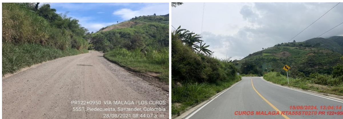
Antes (Fecha de foto: 28/08/2021) y después (Fecha de foto: 09/01/2024) PR122+950. Pavimentación de la vía. Sector atendido y a la fecha se encuentra igual a la foto de después.
