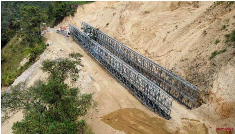
Puente metálico PR111+350 (Fecha de foto: 30/01/2023)
