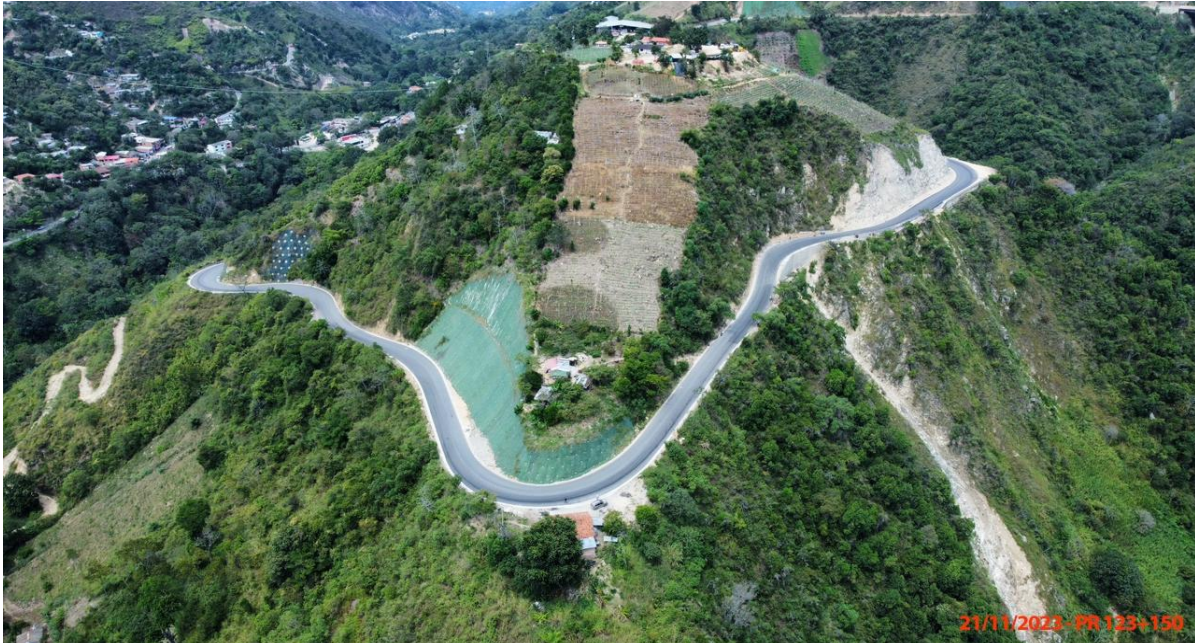
Panorámica antes (Fecha de foto: 21/11/2023) PR123+150. Pavimentación de la vía. Sector atendido y a la fecha se encuentra igual.
