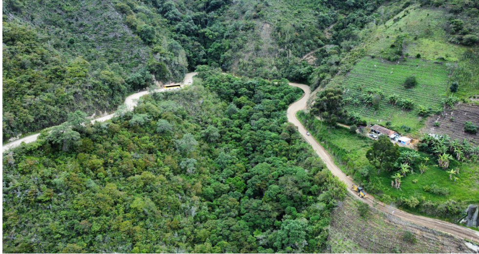
Panoramica – Actividades de mantenimiento.
