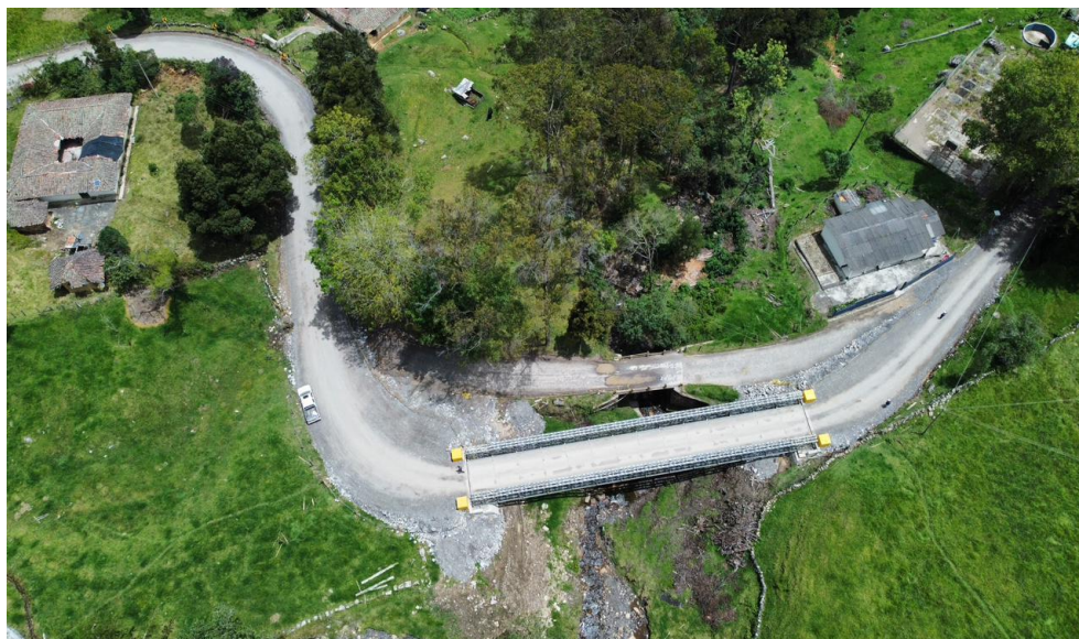
Panoramica (después) (Fecha de foto: 6/08/2024)
