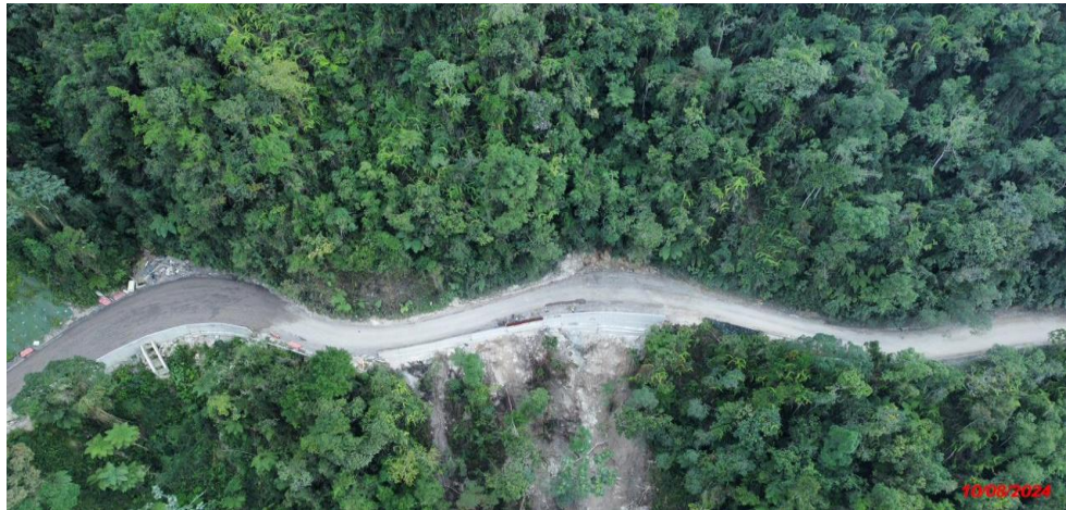
Panoramica (después) (Fecha de foto: 10/08/2024)
