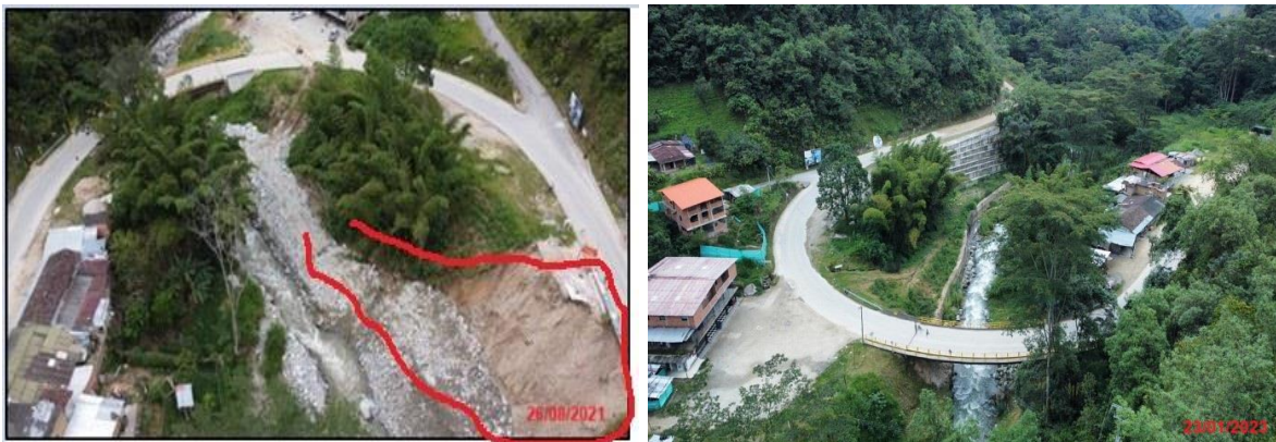
Antes (Fecha de foto: 26/08/2021) y después (Fecha de foto: 23/01/2023), PR95+250. Obras de protección a la vía.
