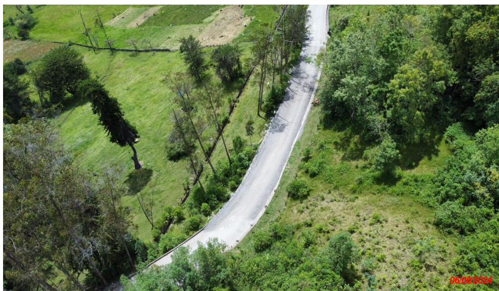
Panoramica (después) (Fecha de foto: 6/08/2024)
