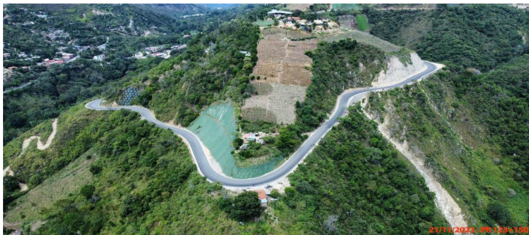
Panorámica antes (Fecha de foto: 21/11/2023) PR123+150. Pavimentación de la vía. Sector atendido y a la fecha se encuentra igual.
