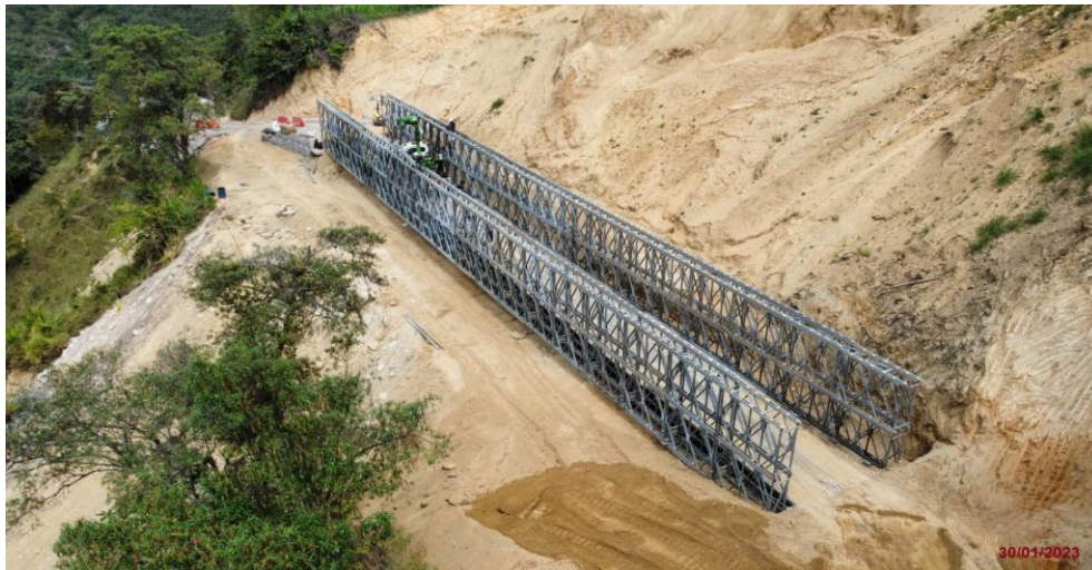
Puente metálico PR111+350 (Fecha de foto: 30/01/2023)
