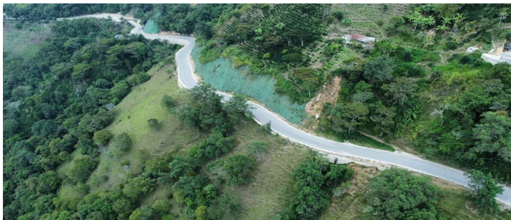
Panorámica (Fecha de foto: 15/05/2024) PR110+400. Pavimentación de la vía. Actualmente el sector se encuentra igual.
