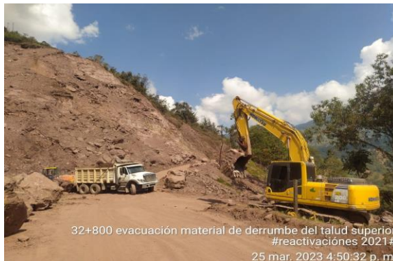
Antes (Fecha de foto: 25/03/2023) y después (Fecha de foto: 17/06/2023). Retiro del derrumbe PR32+800.
