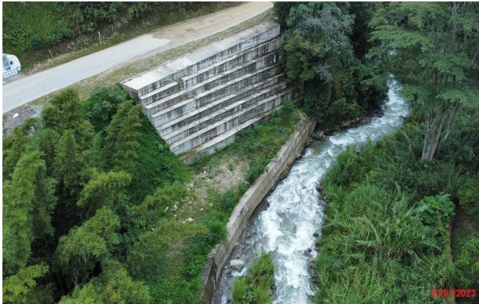
Después (Fecha de foto: 23/01/2023), PR95+250. Obras de protección a la vía.
