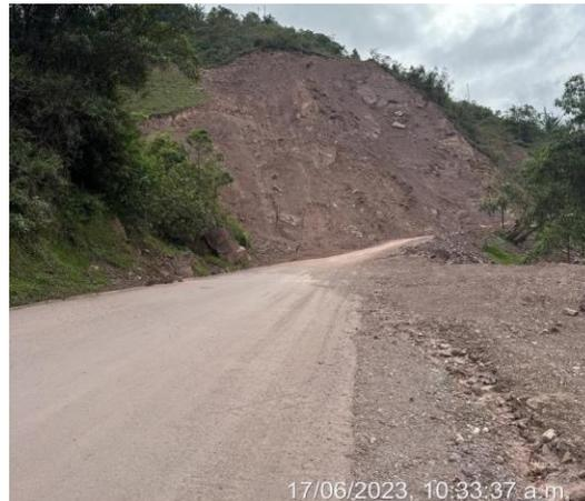
*Antes (Fecha de foto: 25/03/2023) y después (Fecha de foto: 17/06/2023). Retiro del derrumbe PR32+800.*
