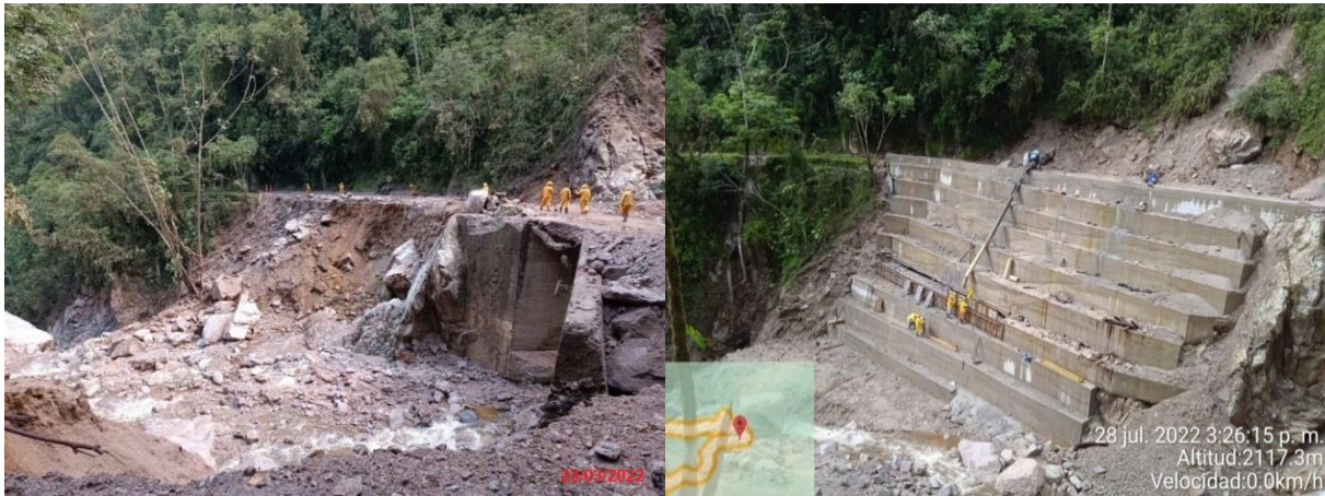
Antes (Fecha de foto: 23/03/2022) y después (Fecha de foto: 28/07/2022) Construcción muro de contención en pérdida de banca PR88+400.
