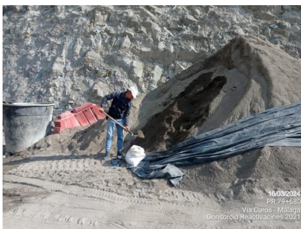
Toma de muestras para caracterización de materiales
