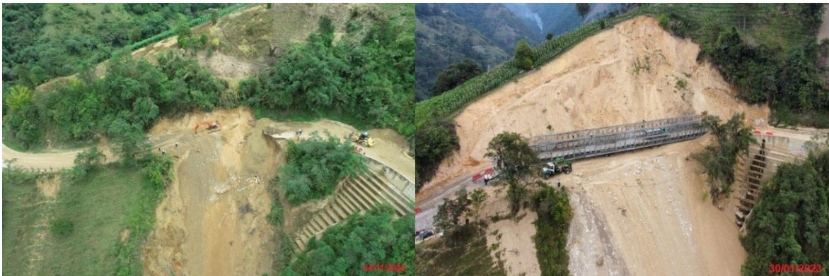
Antes (Fecha de foto: 24/11/2022) y después (Fecha de foto: 30/01/2023). Atención de la emergencia en el PR111+350. Instalación de puente metálico.
