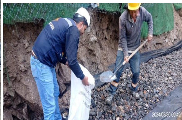
Toma de muestras para caracterización de materiales
