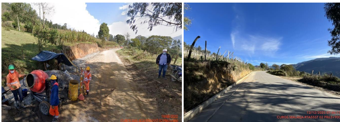
Antes (Fecha de foto: 19/08/2022) y después (Fecha de foto: 12/12/2023) PR63+900 Ampliación y pavimentación de la vía.
