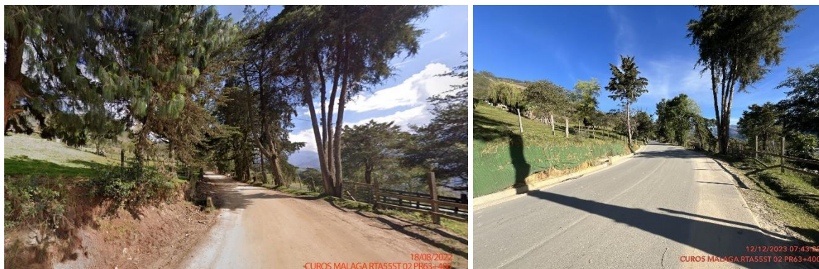
Antes (Fecha de foto: 18/08/2022) y después (Fecha de foto: 12/12/2023) PR63+400. Ampliación y pavimentación de la vía.
