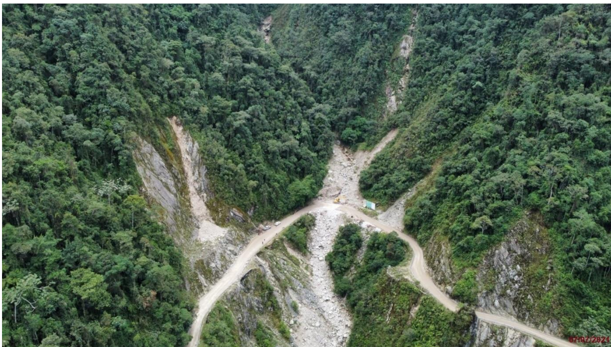
Antes sitio La Judía (Fecha de foto: 07/07/2021), PR79+900. Cause con alto depósito de materiales.
