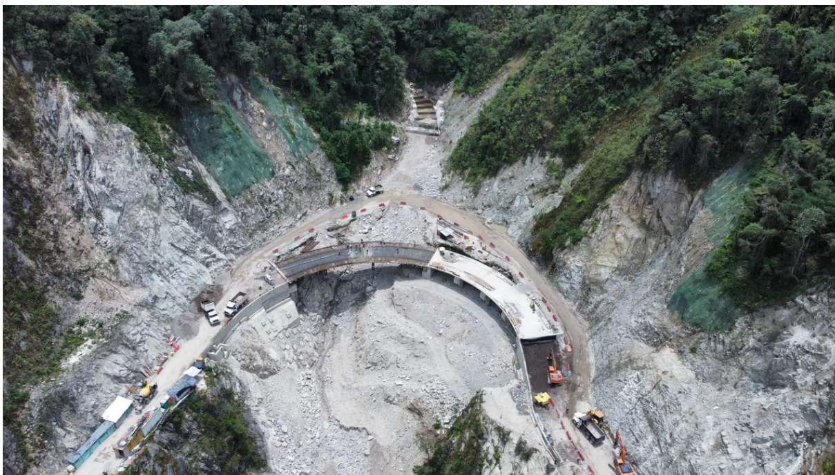
Ejecución en sitio La Judía (Fecha de foto: 08/04/2024), PR79+900. Construcción de puente.
