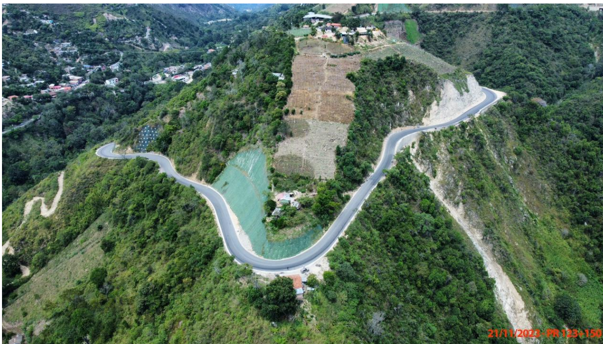
Panorámica antes (Fecha de foto: 21/11/2023) PR123+150. Pavimentación de la vía
