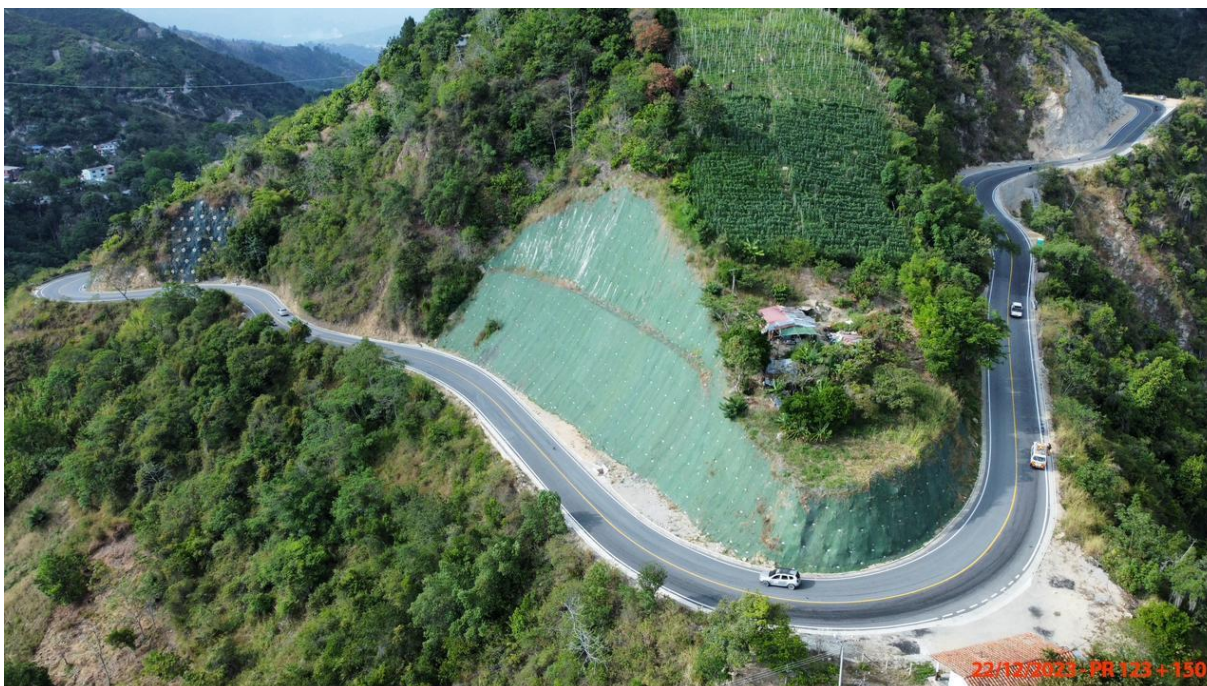
Panorámica después (Fecha de foto: 22/12/2023) PR123+150. Pavimentación y señalización de la vía
