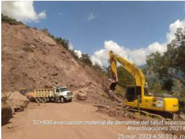
32+800 evacuación material de derrumbe del talud superior
