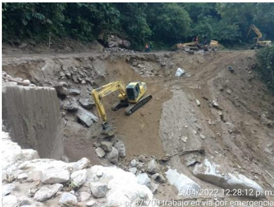
PR 87+930 PERFILADO DE TERRENO PARA ACCESO DE MAQUINARIA AL TALUD INFERIOR
