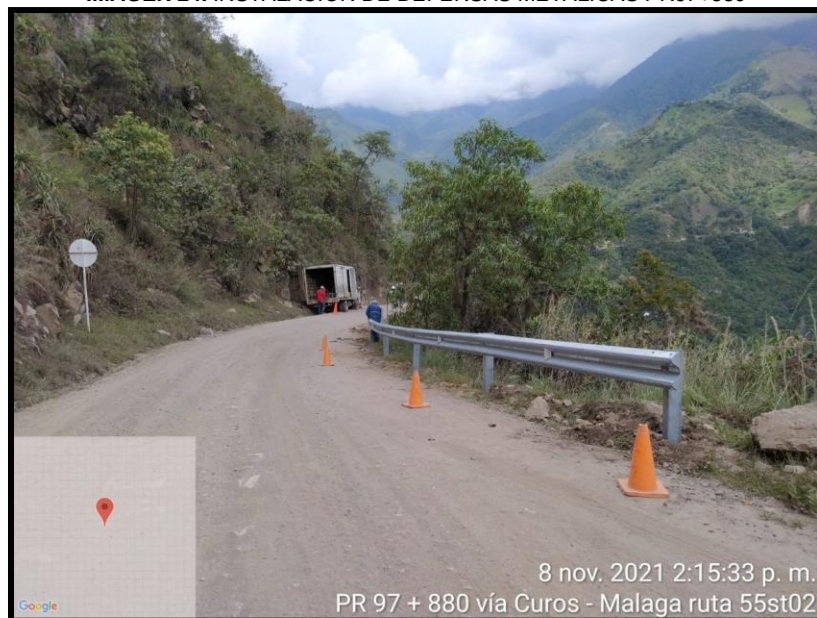
IMAGEN 24. INSTALACIÓN DE DEFENSAS METÁLICAS PR97+880
