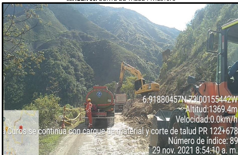
IMAGEN 36. CORTE DE TALUD PR123+678
