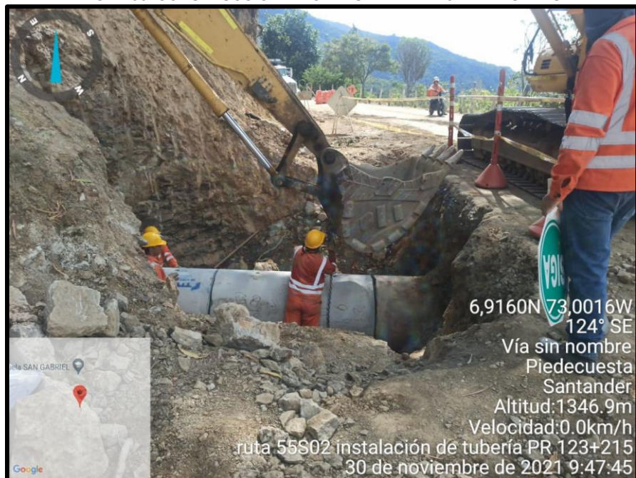
IMAGEN 35. CONSTRUCCION DE OBRAS DE DRENAJE TRANSVERSAL
