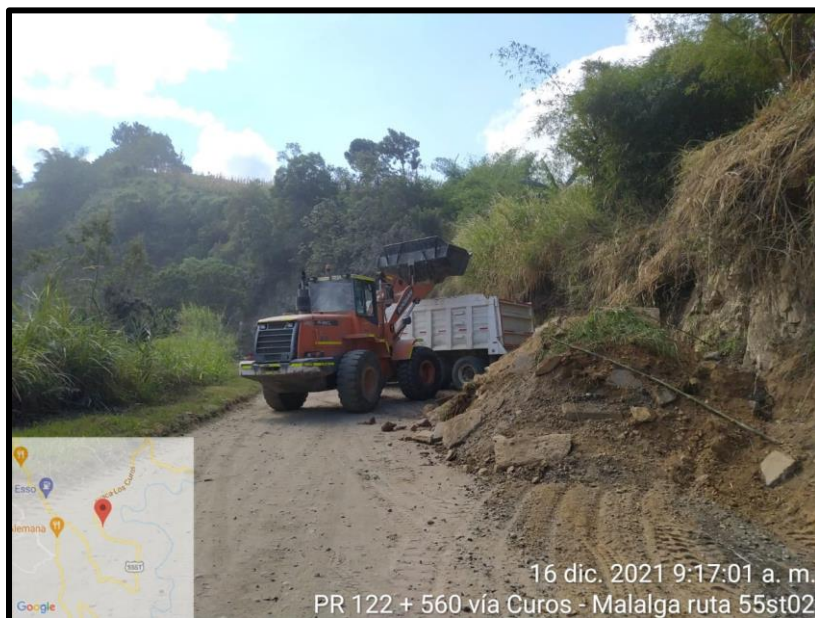
IMAGEN 41 CORTE DE TALUD PR122+560
