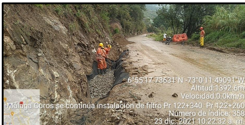
IMAGEN 40. CONSTRUCCION DE OBRAS DE DRENAJE LONGITUDINAL PR122+340
