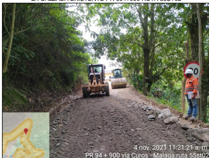
IMAGEN 10. ACTIVIDADES DE INTERVENCIÓN DE LA VÍA A TRAVÉS DE MANTENIMIENTO CON CONFORMACIÓN DE LA CALZADA EXISTENTE PR 094+900 RUTA 55ST02
