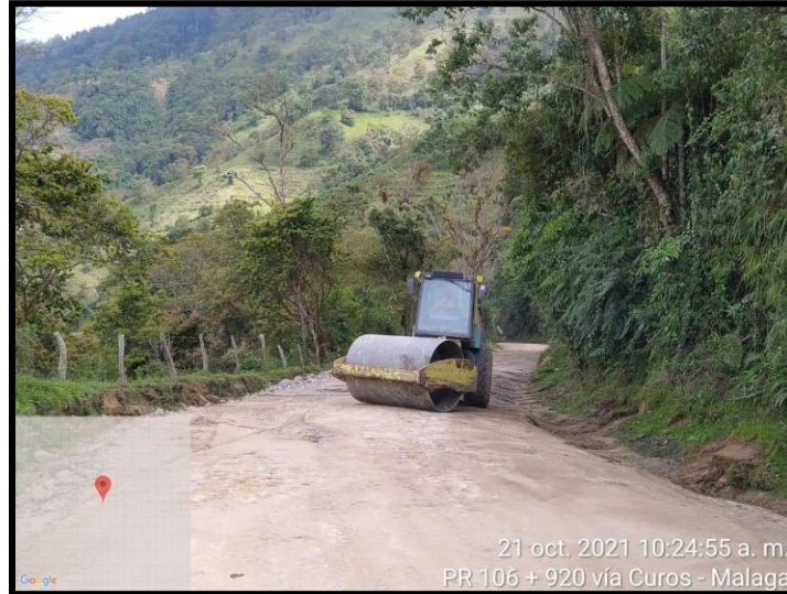
IMAGEN 13. ACTIVIDADES DE ADICION DE MATERIAL PARA MEJORAMIENTO DE SUBRASANTE PR106+0920
