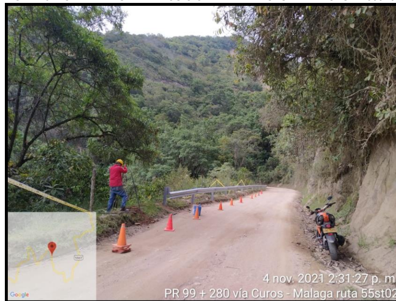
IMAGEN 25. ACTIVIDADES DE REPOSICIÓN DE DEFENSAS METÁLICAS PR099+0280
