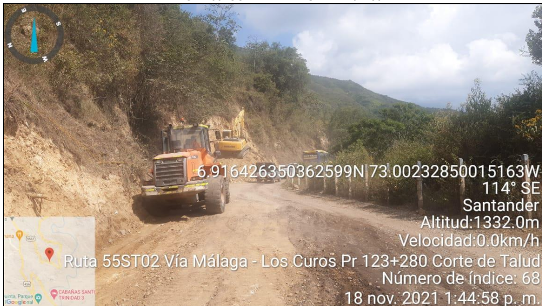
IMAGEN 33. CORTE DE TALUD PR123+280
