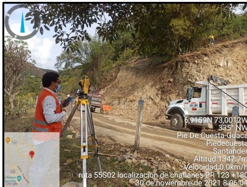
IMAGEN 32. ACTIVIDADES DE VERIFICACION DE VOLUMENES DE CORTE DE TALUDES
