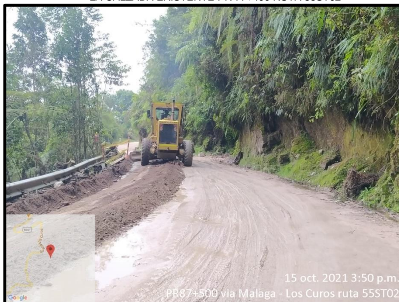
IMAGEN 11. ACTIVIDADES DE INTERVENCIÓN DE LA VÍA A TRAVÉS DE MANTENIMIENTO CON CONFORMACIÓN DE LA CALZADA EXISTENTE PR 77+400 RUTA 55ST02
