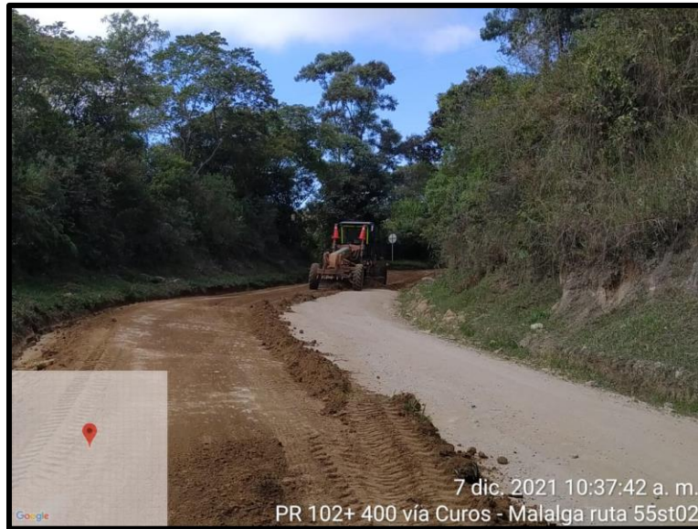
IMAGEN 14. ACTIVIDADES DE ADICION DE MATERIAL PARA MEJORAMIENTO DE SUBRASANTE PR102+0400
