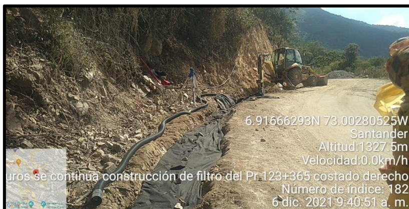
IMAGEN 39. CONSTRUCCION DE OBRAS DE DRENAJE LONGITUDINAL PR123+365
