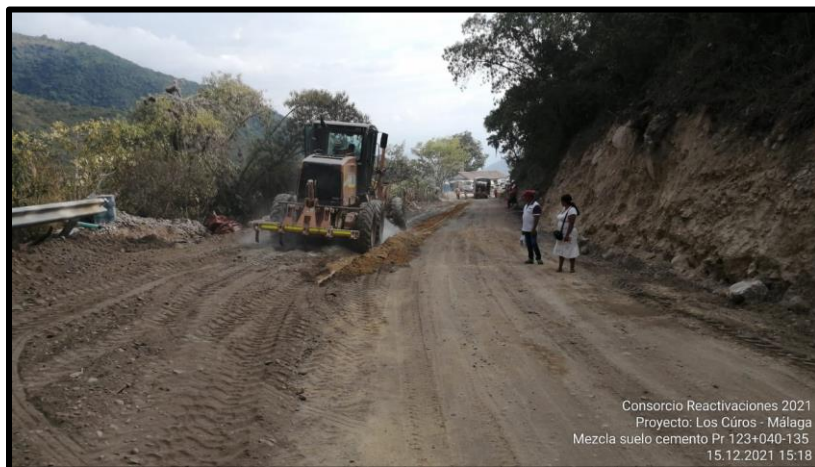
IMAGEN 42. MEJORAMIENTO DE SUBRASANTE EXISTENTE
