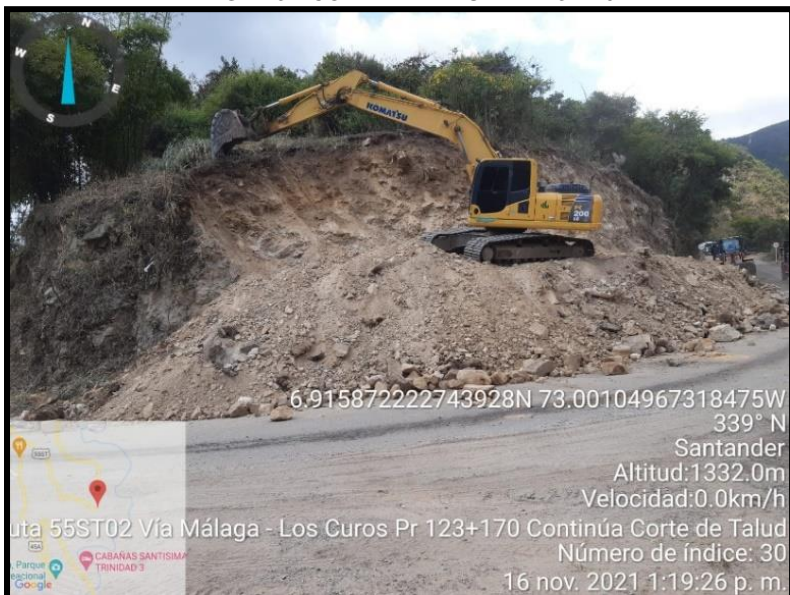
IMAGEN 31. CORTE DE TALUD PR123+170
