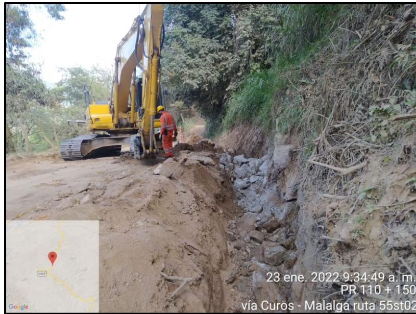
DEMOLICIÓN DE CAJAS DE CONCRETO EXISTENTES PR110+150
