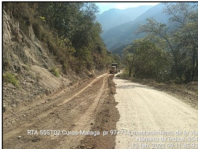
CONFORMACIÓN DE LA CALZADA EXISTENTE PR 097+714 RUTA 55ST02
