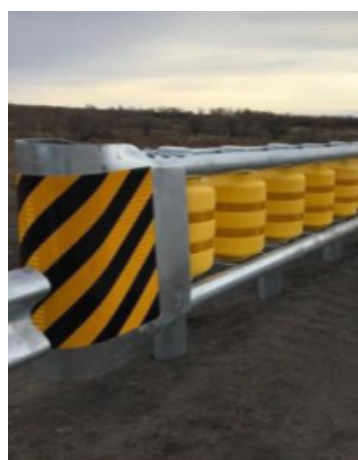
Figura 732-1 Modelo ejemplo de Terminal del Sistema de Barrera de Rodillos – Dimensiones ejemplo en milímetros
