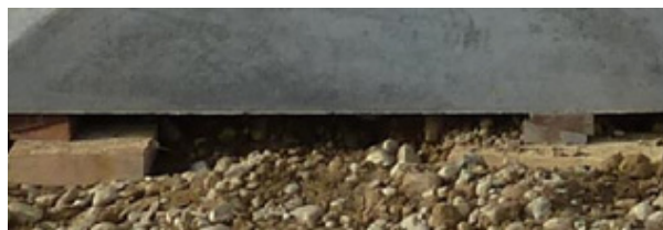
Figura 686-6. Detalle de bloques de apoyo para primera fila de paneles
