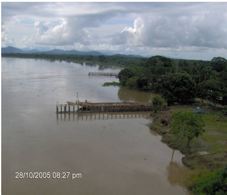
Obras de protección contra la erosión en el sector de Boca del Cura
