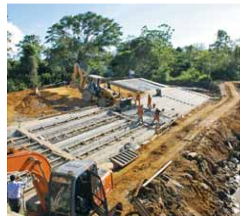
Las obras se están adelantando, especialmente la construcción de muelles. /Invías
