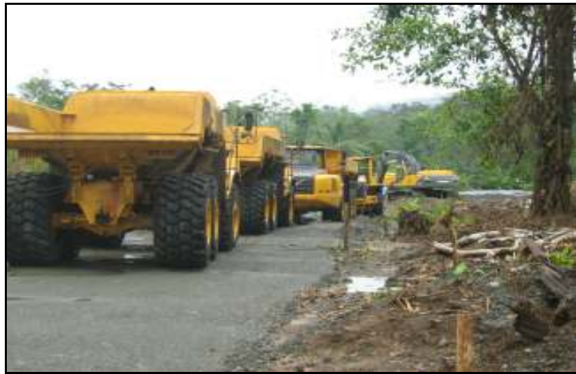
Imagen 10 Maquinaria en frente de obra en el Tramo 5.
