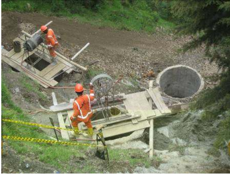
Construcción de Caissons PR 36+923 a PR 37+122 Segunda Calzada del Tolima
