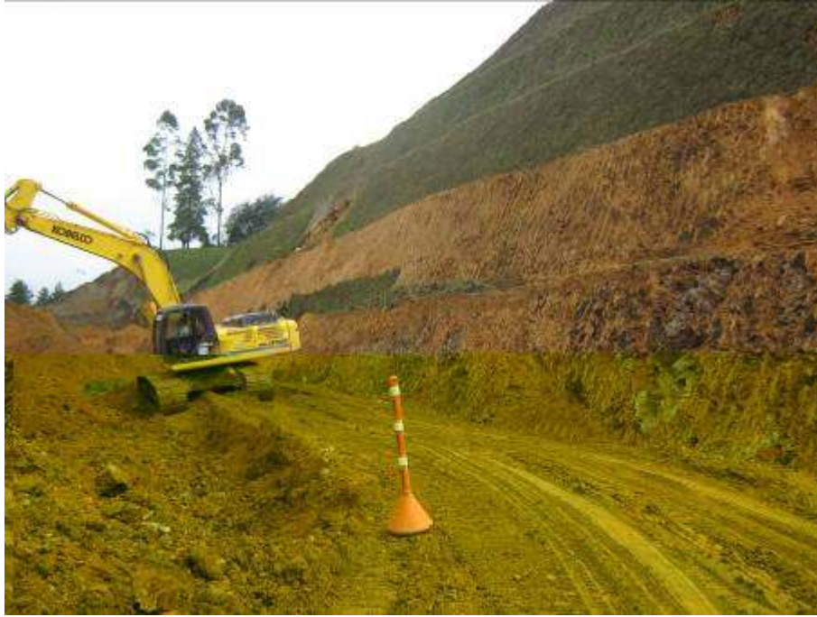
Explanación y Estabilización con prado PR 12+920 Segunda Calzada del Quindío
