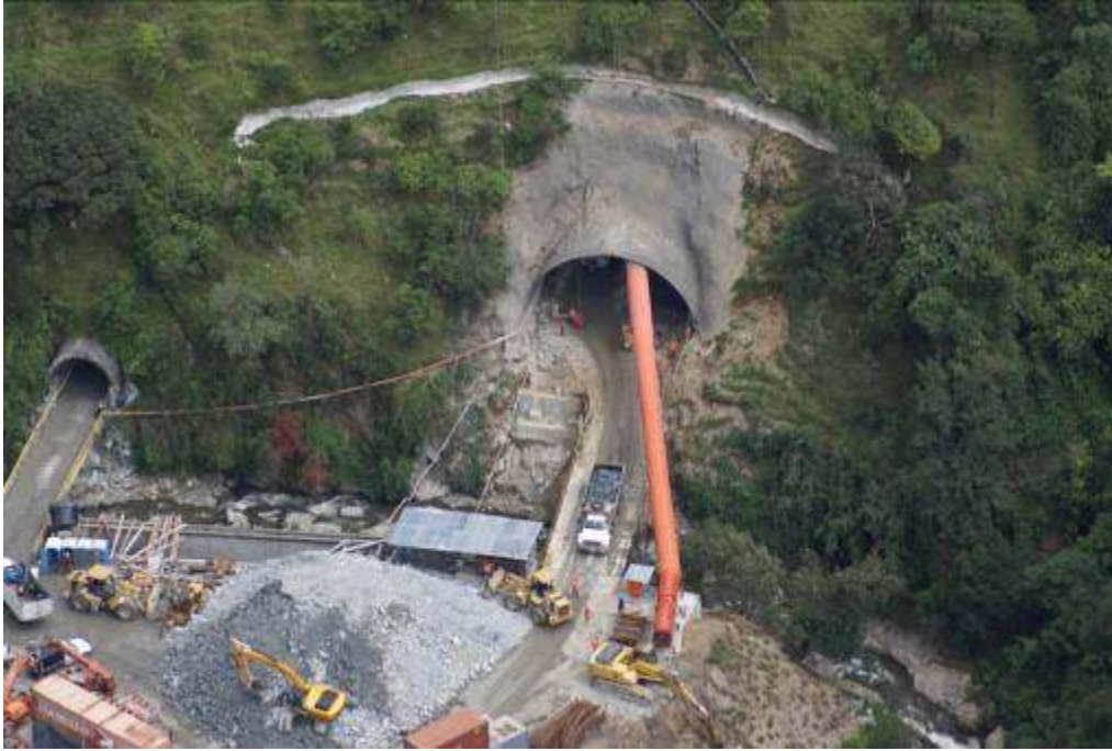
FRENTE TOLIMA TUNEL II CENTENARIO
